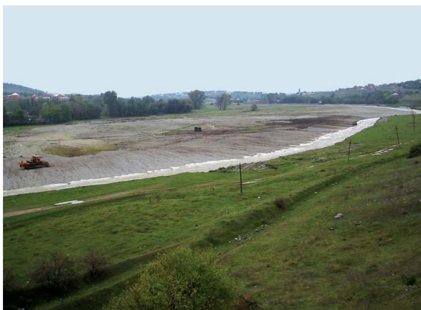
Рис. 3. Руслоочистительные работы на р. Назранка.
