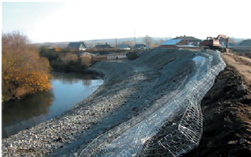
Рис. 3. Укрепление габионными конструкциями дамбы на р. Сылта.
