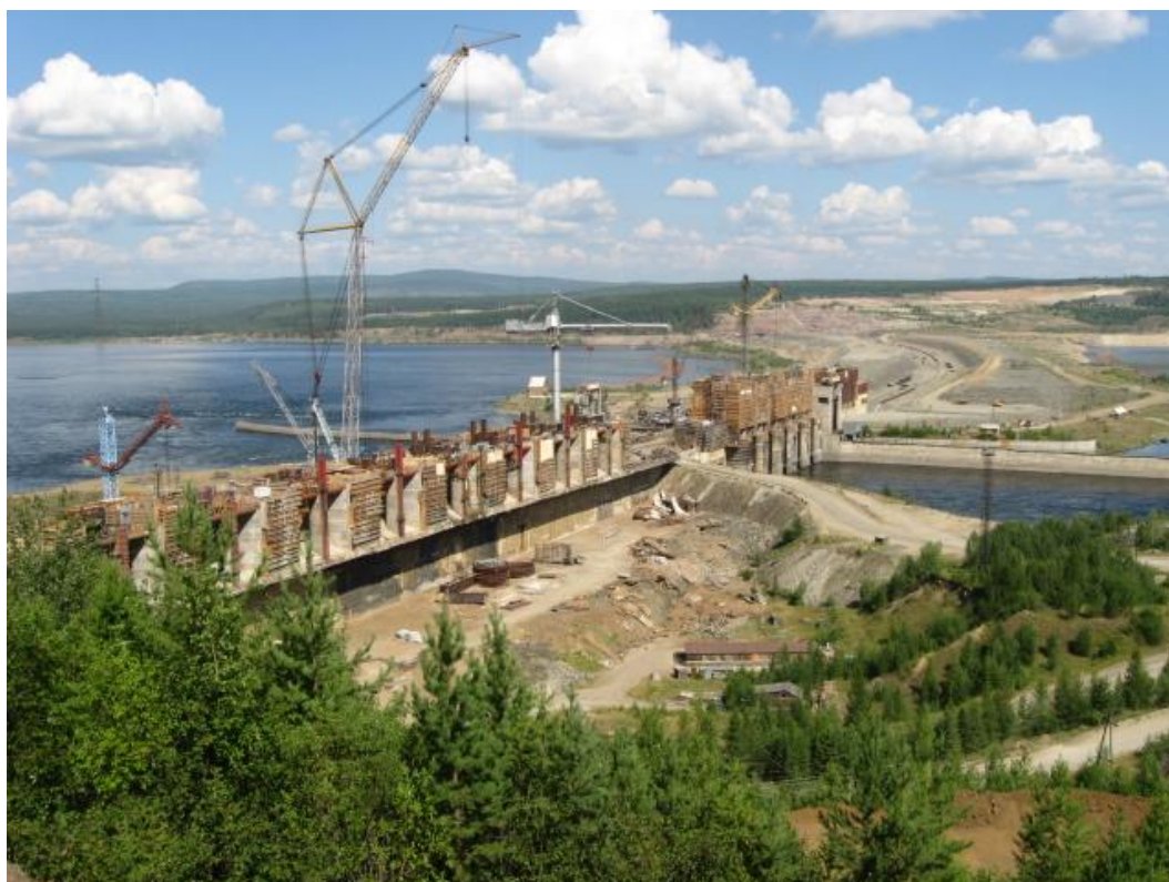
Рис. 1. Общий вид строящейся Богучанской ГЭС.
