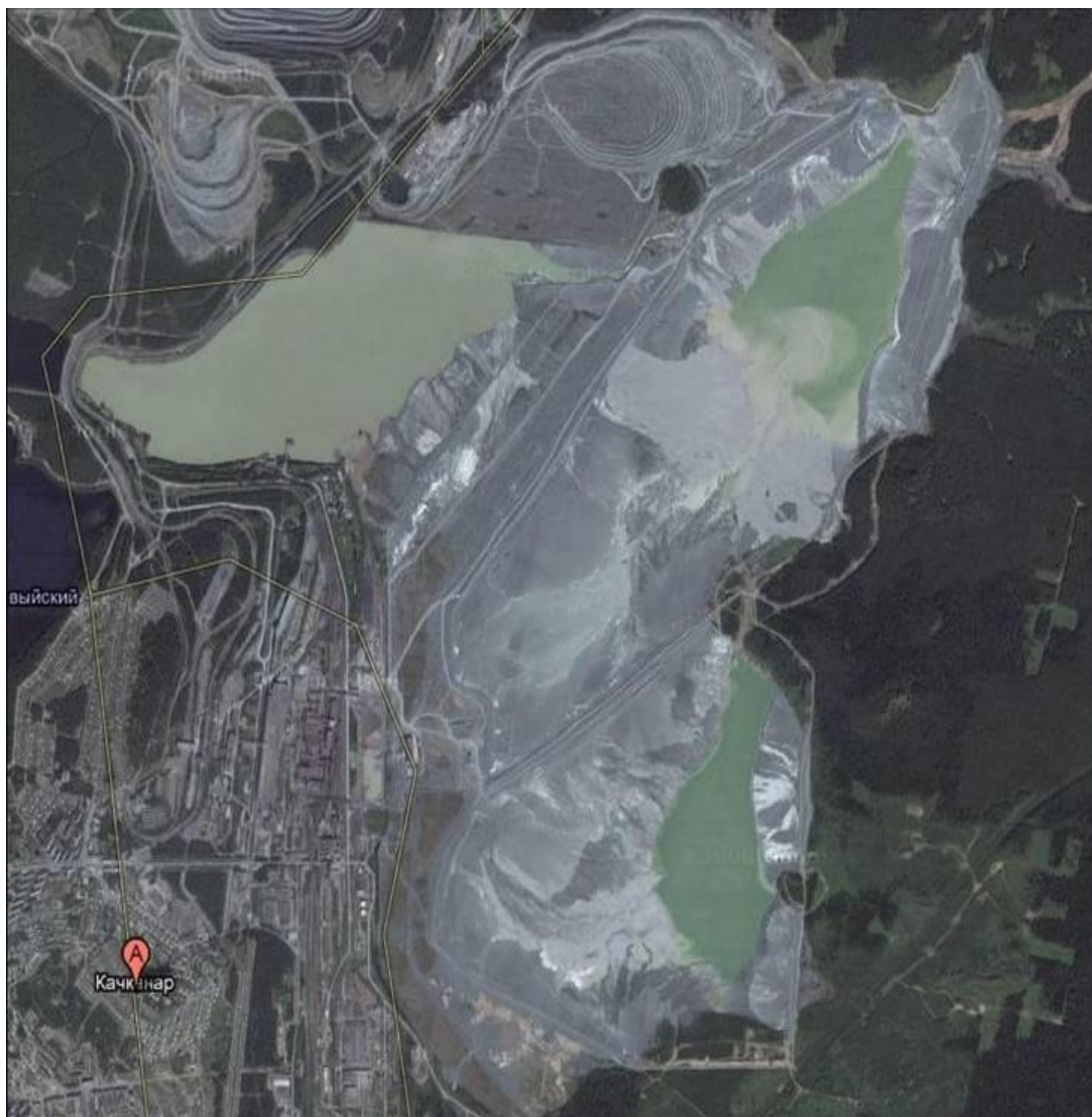
Рис. 2. ГТС хвостохранилища Качканарского ГОКа.
