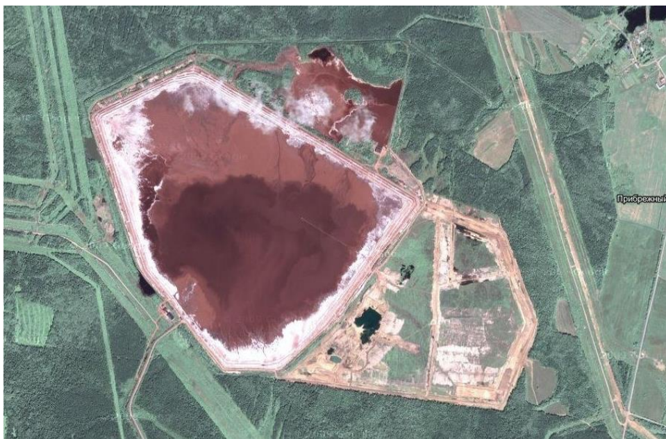
Рис. 3. ГТС шламохранилища № 2 Богословского алюминиевого завода.
