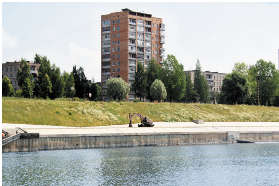
Рис. 4. Защита берега в спальном районе г. Рыбинска.
